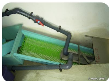
Ci-dessus : De gauche à droite, le bac de piégeage des civelles, la rampe de reptation en brosses, et la libération des individus après biométrie (© MRM)
