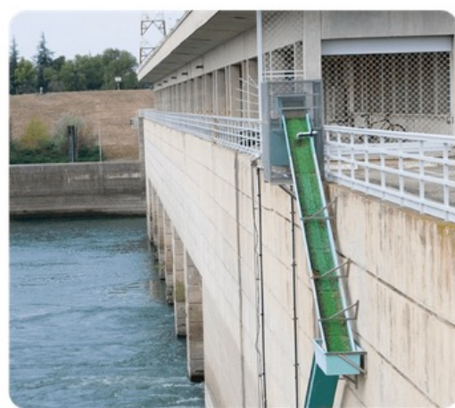
Ci-dessus : La passe Rive Gauche de Beaucaire et les gammes de taille ciblées par les dispositifs de type "passe-piège à anguilles"
