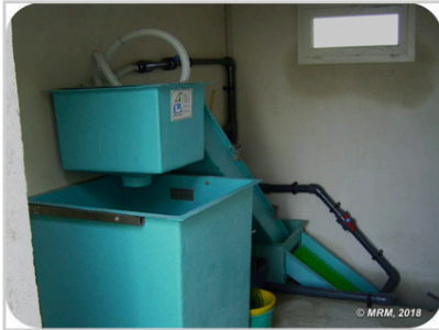
Ci-dessus : De gauche à droite, le bac de piégeage des civelles, la rampe de reptation en brosses, et la libération des individus après biométrie ((C) MRM)
