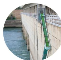
Ci-dessus : De gauche à droite, un bac de piégeage, les gammes de tailles ciblées par le dispositif, la passe piège de la rive gauche du barrage de Beaucaire, le substrat en « brosses » de la passe, adapté à la reptation des anguilles
